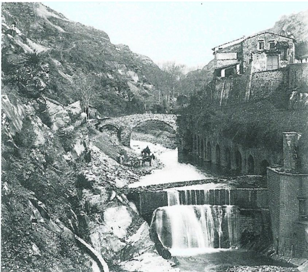
Ponte del Calderaio con le arcate dell'acquedotto e le torrette presso il Serrone.
